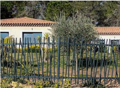
Clôture en métal
