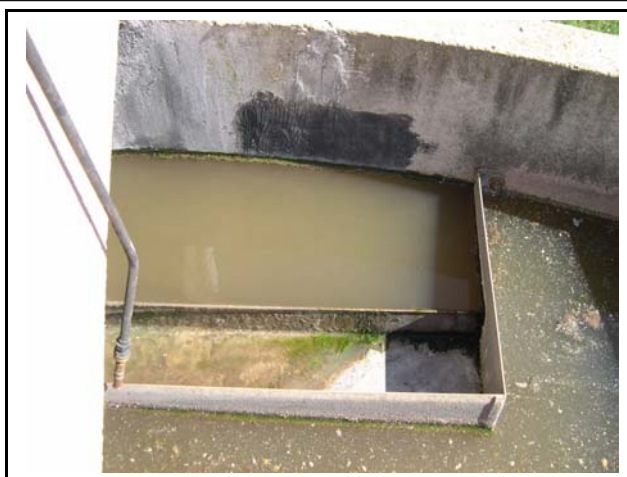
Photo 3 : Décanteur-digesteur
