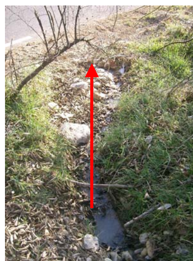
Rejet dans le fossé pluvial
