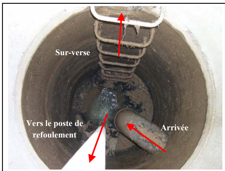
Photo 1 : Regard en amont de la station d'épuration
