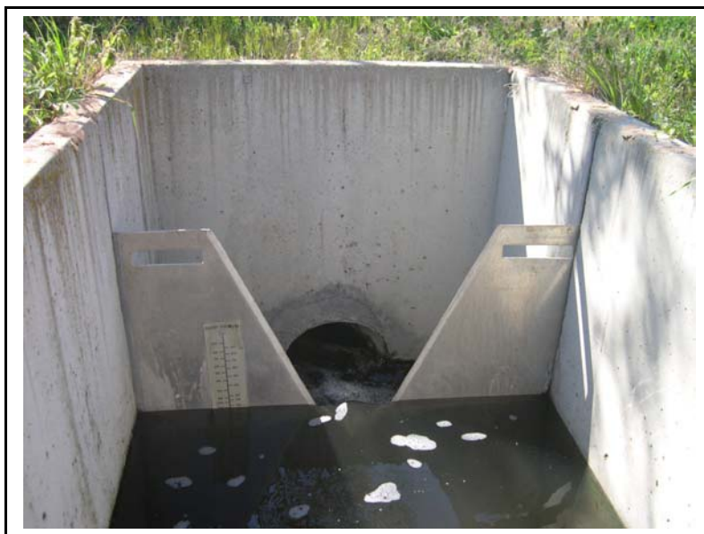
Photo 7 : Canal de sortie
