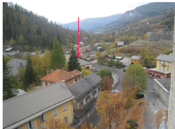
Une centralité à conforter avec la future Halle
