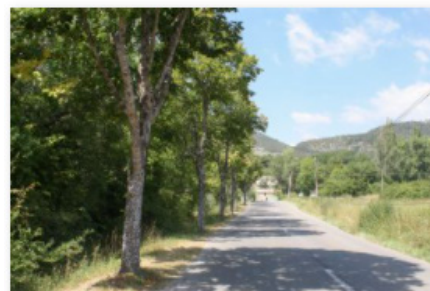
RD 952 fossés et accotements enherbés (L. Palud-sur-Verdon)
