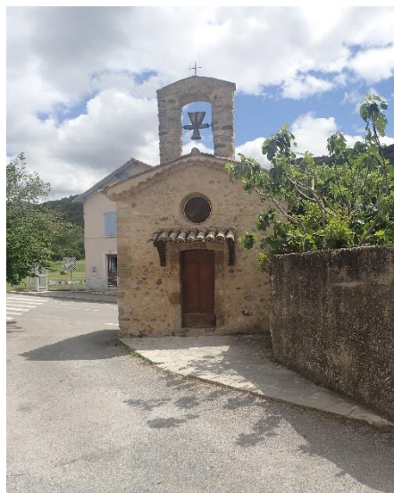
Photographie 47 : Chapelle Saint-Louis
