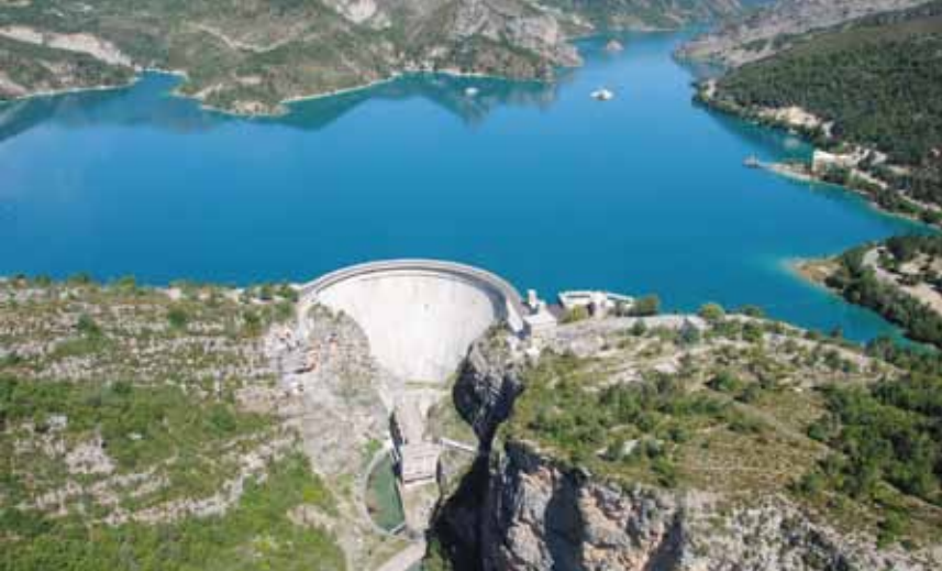
Barrage de Castillon
