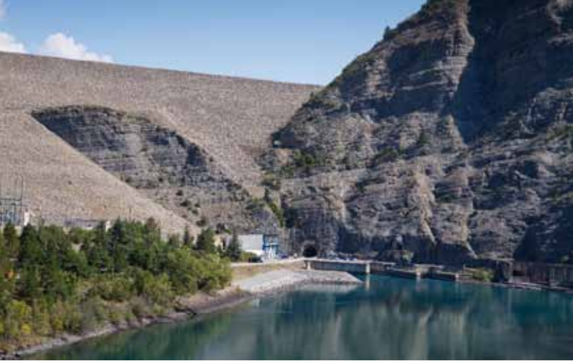
Barrage de Serre-Ponçon
