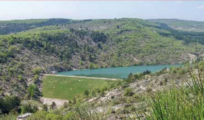
Barrage de La Laye
