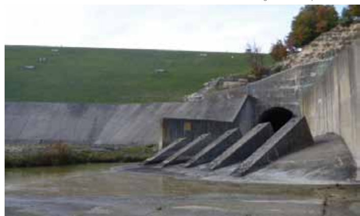
Barrage de La Laye
