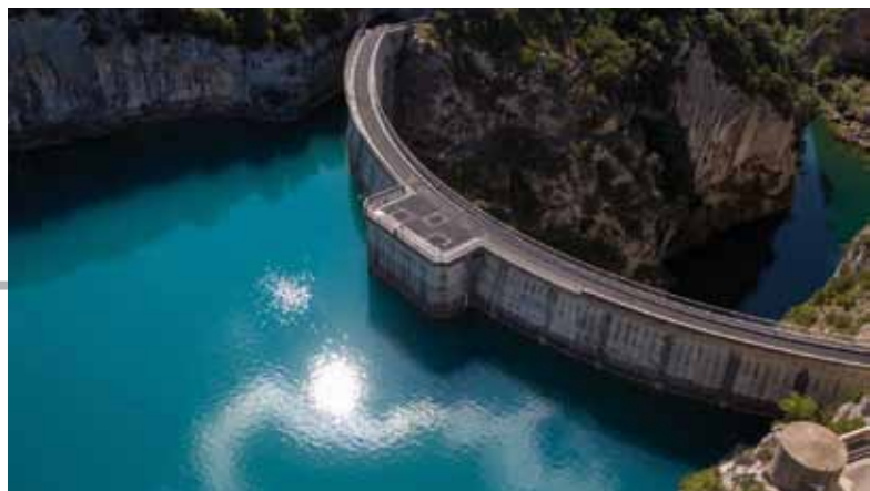
Barrage de Sainte-Croix du Verdon
