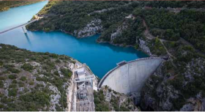
Barrage de Sainte-Croix du Verdon
