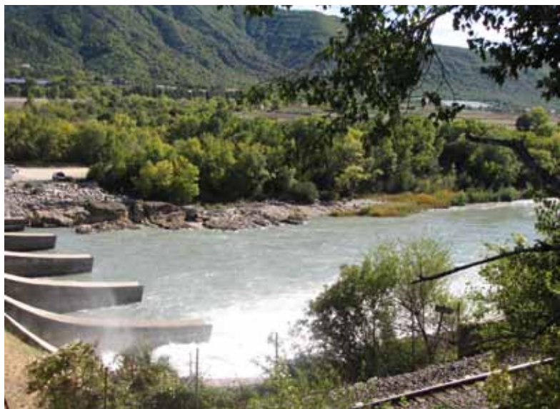
Barrage de Château-Arnoux
