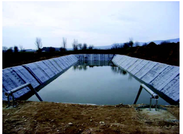
Réserve incendie 1500 m 3
