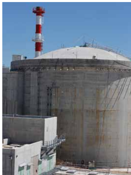
Chantier réacteur RJH
