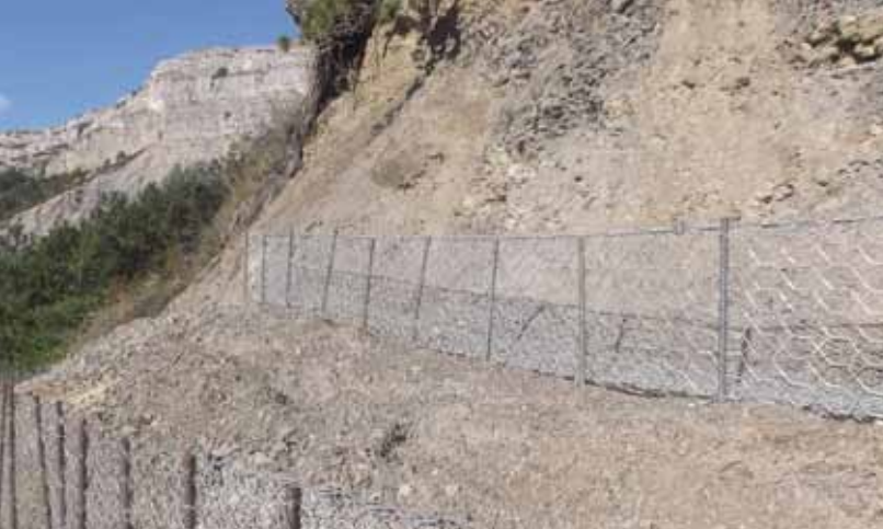
Banquettes grillagées Col du Corobin
