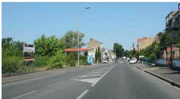
RD 906 (avenue Poincaré) en provenance d'Abrest
