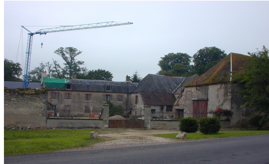
Le château de la Baume en cours de restauration
