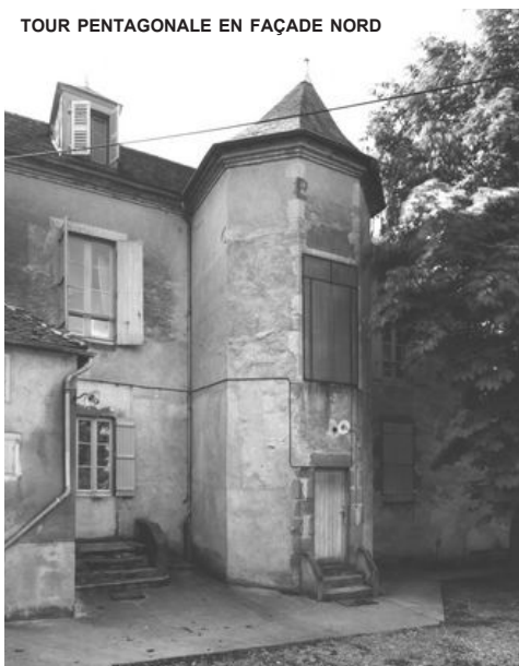
TOUR PENTAGONALE EN FAÇADE NORD
