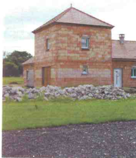
constructions neuves très demandées
