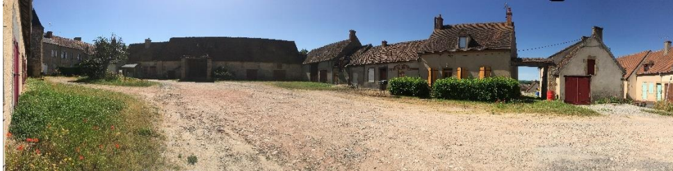
Ensemble bâti impasse du Couvent
