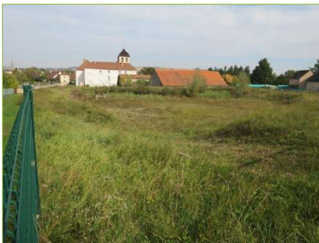
Bassin de rétention à Saint-Germain-des-Fossés - surplomb du Prieuré
