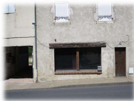
Vacance rue Pierre Sépard
