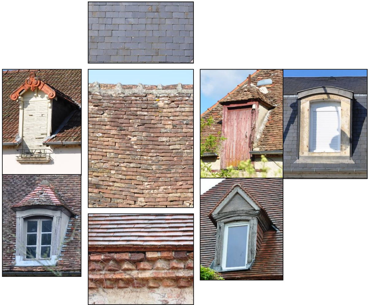
Toitures en tuiles plates ou mécaniques, parfois en ardoises, corniches en briques, nombreuses lucarnes aux formes variées
