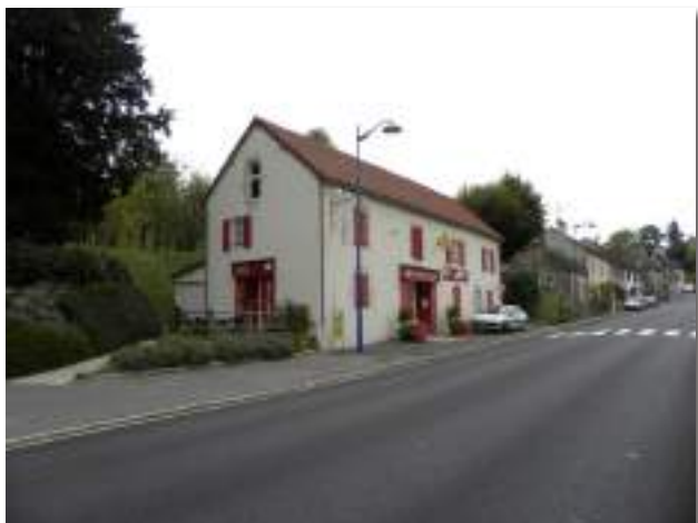
Vues de la Route de Vichy (RD6), avec les voitures sur les trottoirs et les quelques aménagements effectués par de la signalisation au sol, mais éloignés des commerces.
