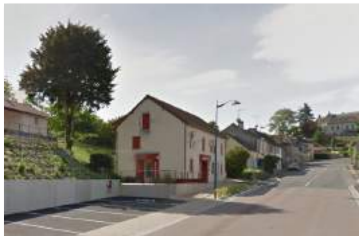
Vue de la Route de Vichy après la réalisation des aménagements (piéton, rampe d'accès, places de parking,...)
