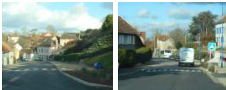
Source : aménagement des trottoirs et plateau surélevé
