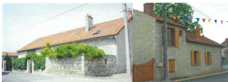
Maisons du bourg réhabilitées
