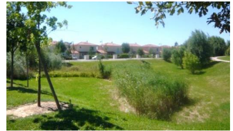
Bassin de rétention paysager
