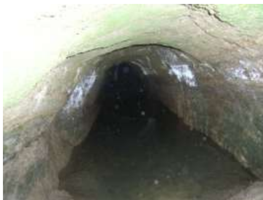
Photo 8 : Galerie n°1 vue de l'entrée
