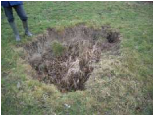
Photo 1 : Fontis à l'aplomb des travaux du bois Girard (F4)
