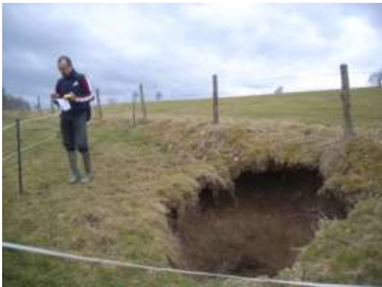
Photo 2 : Fontis à l'aplomb des travaux Saint Claude (F23)
