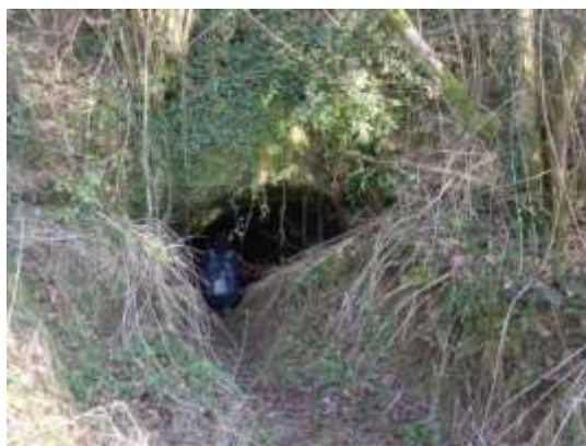
Photo 7 : Entrée de la galerie n°1
