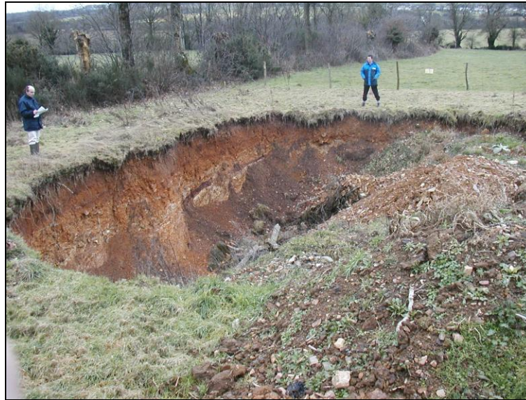
Illustration 6 : Effondrement localisé de grande dimension
