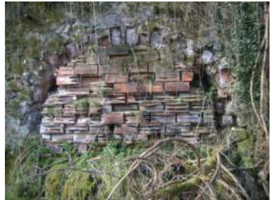
Photo 4 : Galerie de la centrale (G25)
