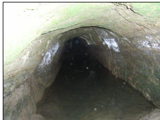
Photo 2 : Corps de la galerie n° 1 (G2) (Photo INERIS)
