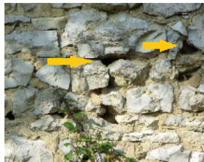
Deux cavités conservées dans un mur
