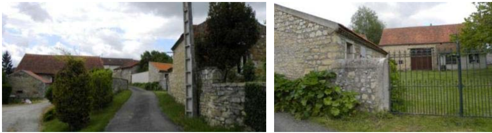
Anciens bâtiments d'habitation en pierre dans le bourg
