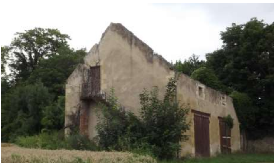
Bâtiment agricole désaffecté au sud du lieu-dit les Mûres
