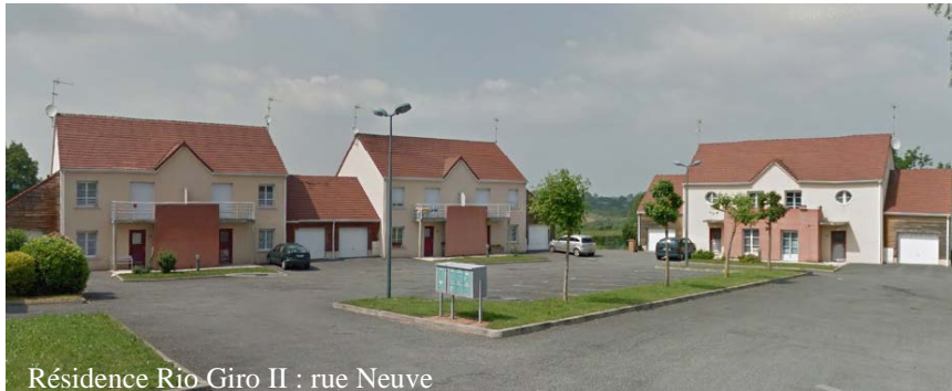
Résidence Rio Giro II : rue Neuve
