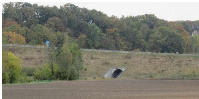
Figure 2 - Cours d'eau busé sous l'A719
