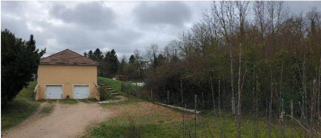
Maison isolée au niveau de la rue George Ferrier
