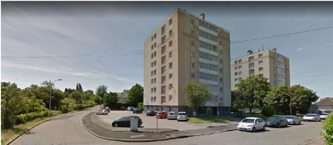
Bâtiment d'habitat collectif de la rue des Iris
