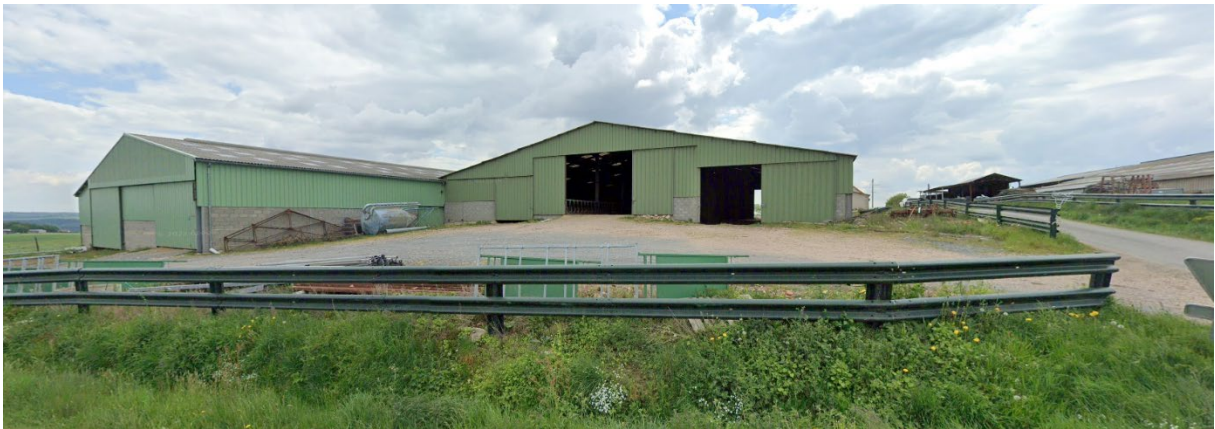
Figure 90 : Photographie d'un bâtiment agricole au niveau de la RD116 (Source : Google Street View)
