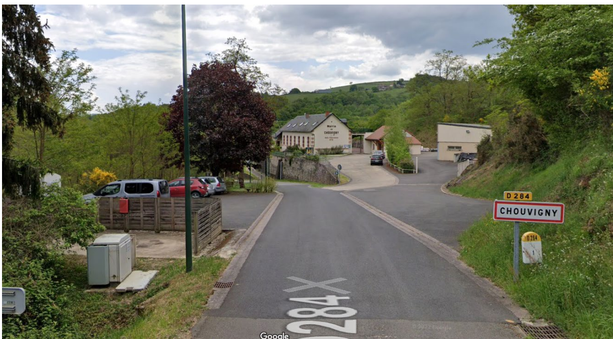
Figure 98 : Entrée de ville donnant directement sur le bourg depuis la route départementale 284 (Source : Google Street View)
