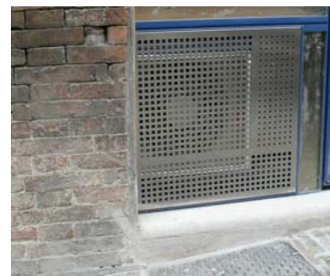
Les climatiseurs ne doivent pas apparaître ; il est placé ici derrière une grille, dans la baie d'une devanture (Urbino, Italie)
