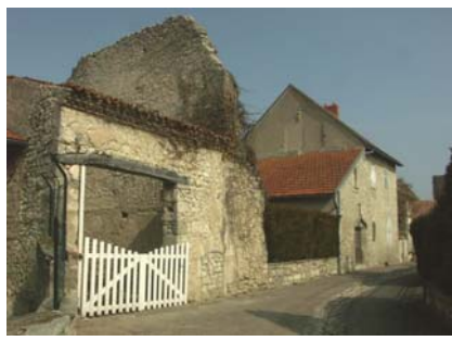
Mur pignon médiéval
