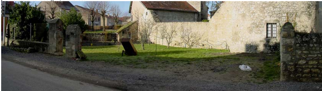
La douve doit être maintenue en herbe, nivelée en creux, en se rapprochant du niveau ancien, et protégée par un mur bahut sur sa contrescarpe.
