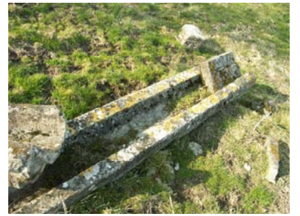
Une installation hydraulique
