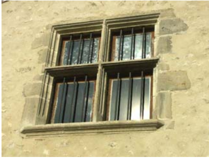
Les fenêtres à meneaux
