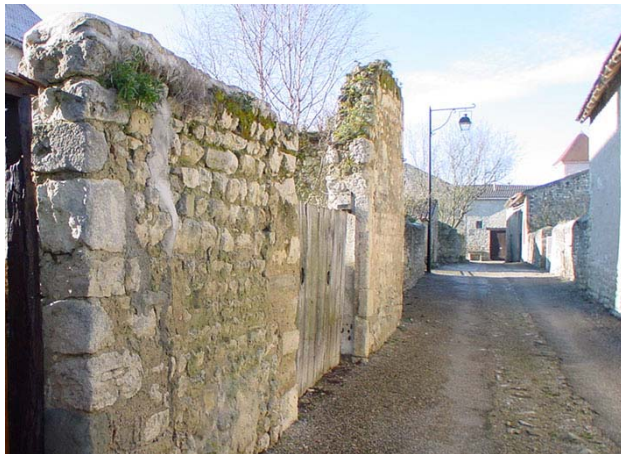
Un mur issu d'une ancienne maison démolie à maintenir, comme structure de la rue
