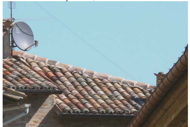
Quand une antenne ne peut être implantée hors de la vue de l'espace public, une position discrète et une coloration de la parabole permettent d'assurer la discrétion de l'installation
