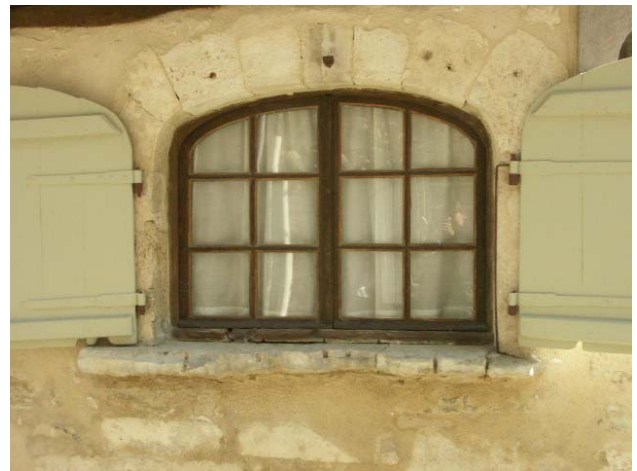
Lorsque la baie présente une forme particulière, la menuiserie doit épouser la forme de la maçonnerie
