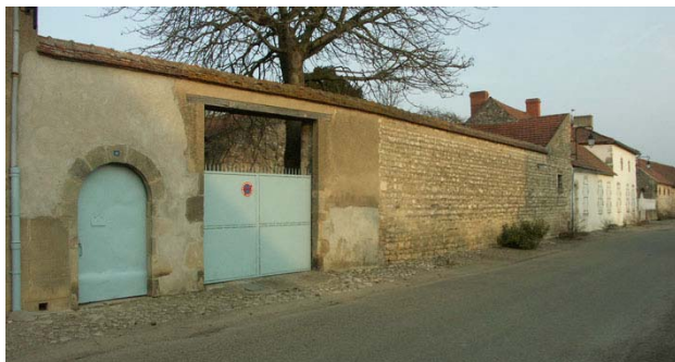
Un grand mur en continuité de la propriété
