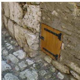
Coffrets techniques : par un volet en bois ; on peut aussi réaliser un couvercle avec l'insertion de la pierre dans un cadre
