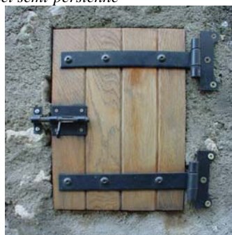
Volet d'armoires techniques (armoires électriques, compteurs, vannes, etc)
