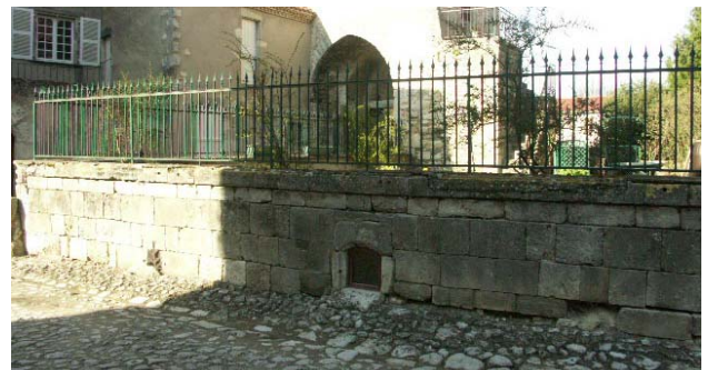
Le mur-bahut, avec sa base maçonné et sa grille en ferronnerie
