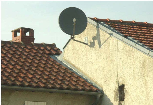
Quand une antenne ne peut être implantée hors de la vue de l'espace public, une position discrète et une coloration de la parabole permettent d'assurer la discrétion de l'installation
