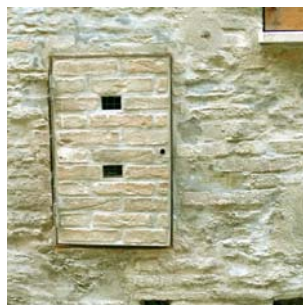
Coffrets techniques : par un volet en bois ; on peut aussi réaliser un couvercle avec l'insertion de la pierre dans un cadre
