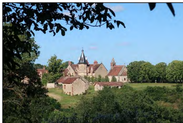
Château de la Crête sur la commune de Audes Source : Artifex 2020
