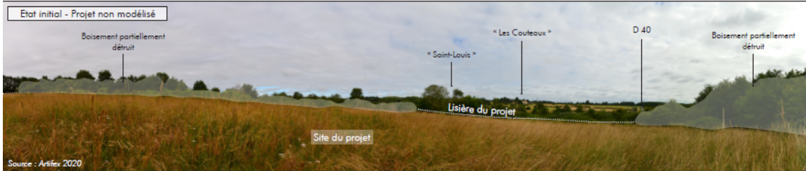
> Perception représentative du projet à l'échelle du site depuis le Nord du site
