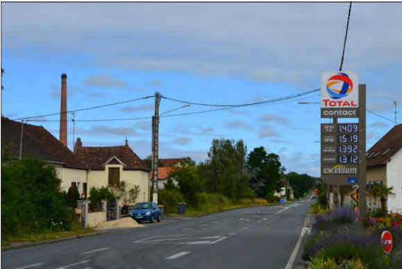
Route départementale D 843 Source : Artifex 2020
