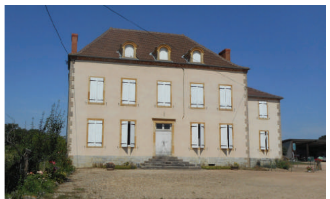
Éléments bâti d'habitations
