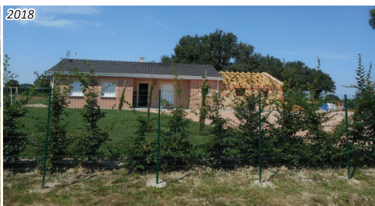
Construction n°2 au Nord du bourg, le long de la RD169
