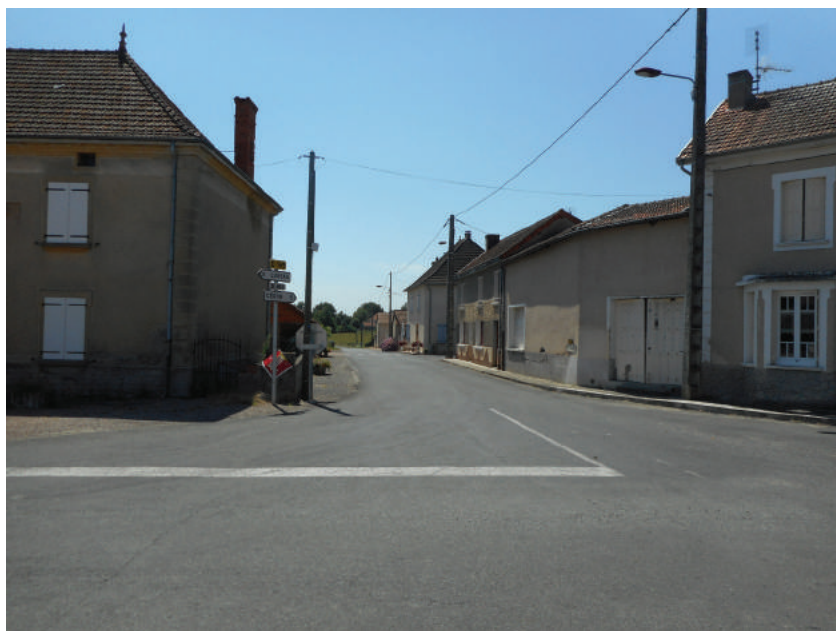
Constructions dans le bourg en front bâti
