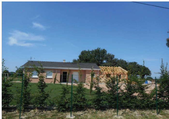
Urbanisation pavillonnaire Source : Visite de site
