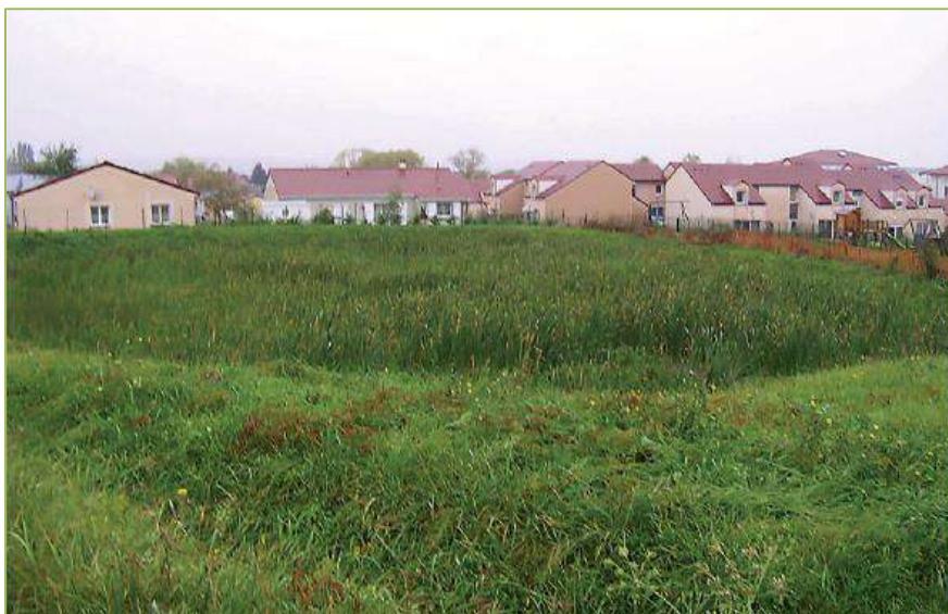
Bassin de rétention à Cusset (source : plaquette « Intégrer la gestion des eaux pluviales dans un projet d'aménagement » de Vichy)
