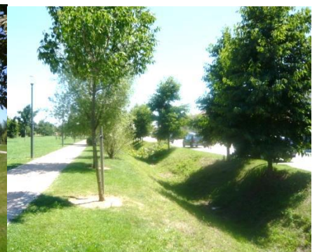
Bassin de rétention paysager
