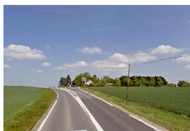
RD 1 en entrée de ville
