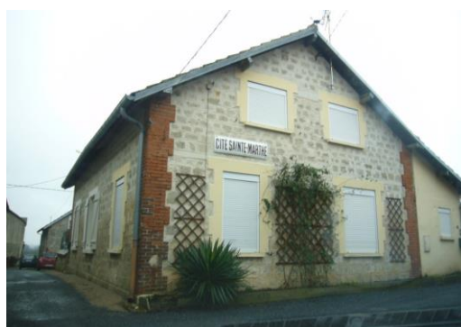
Entrée de la cité Sainte-Marthe, rue du Courty Montier
