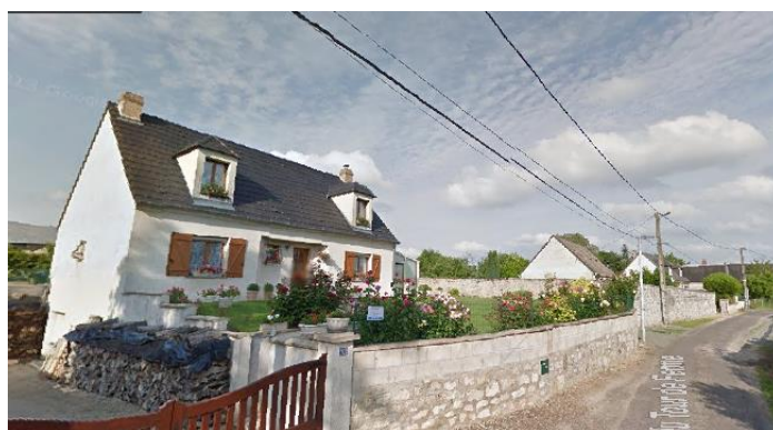
Rue du Tour de Ferme (source : Google Maps)
