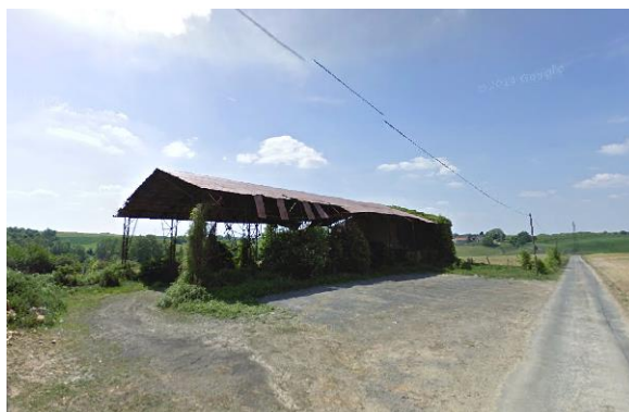
Bâtiment agricole à l'Ouest du finage (source : Google Maps)
