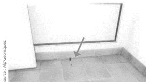
Affaissement du plancher mis en évidence par le décollement entre plinthes et dallage - Maison Jourdan.
