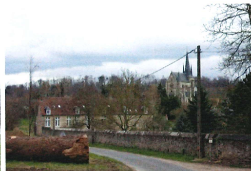
3 : Mur situé en entrée de Royaucourt rue des anciens vignobles
