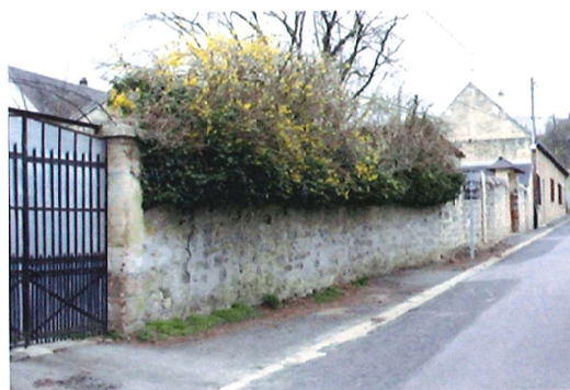
7 : Mur situé au cœur de Chailvet rue de la fontaine
