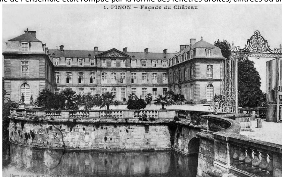
Façade du château avant sa démolition
