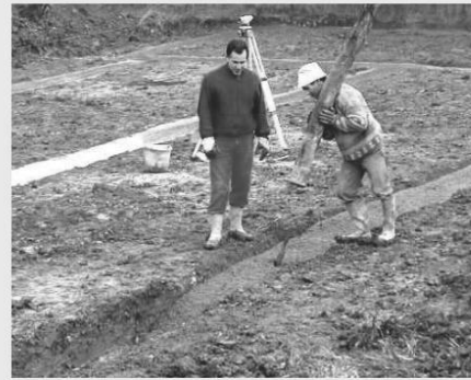
Coulage de fondations d'une habitation sur sols argileux. Sources : AQC
