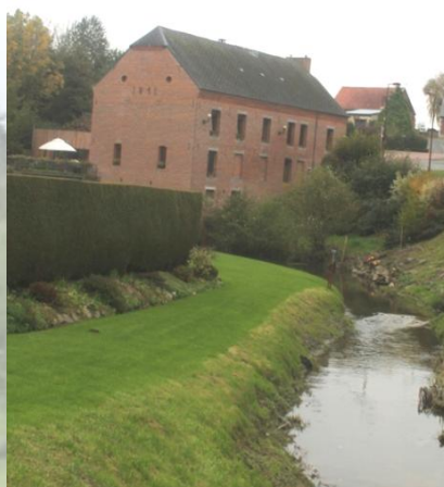
Ancien moulin à eau – demi croupe bâti daté de 1841 présence d'éléments architecturaux décoratifs ouvragés, et d'une lucarne fronton de qualité
