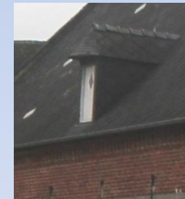
Lucarne : Coupe frontale ronde ou polygonal ressemblant à une lucarne à guitare
