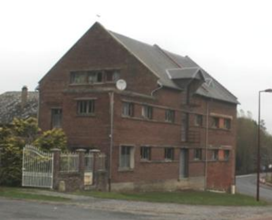
Bati type Moulin à farine et lucarne remonte charge typique
