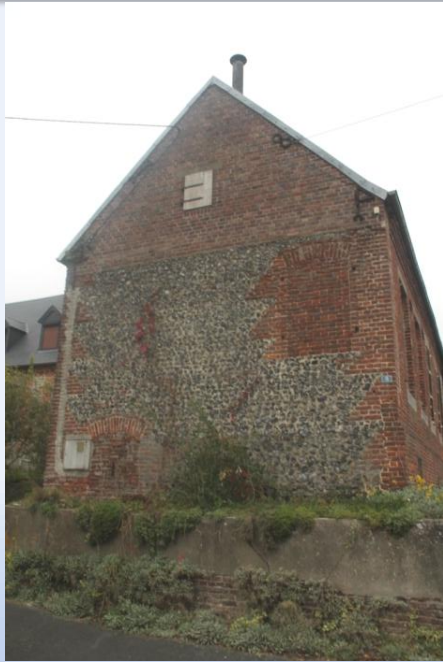
Présence de silex répartis dans un enduit chaux en triangulation
