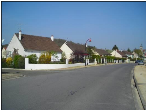
Lotissement rue de Soissons
