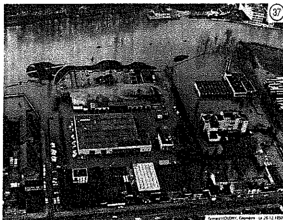
Commune de Soissons crue Aisne de 1993-Source géomètre HOUDRY
