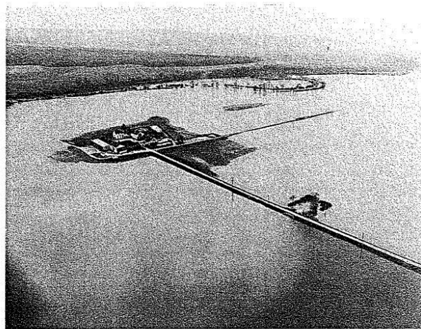
Commune de Pontavert/ ferme « La Pêcherie »/ crue Aisne de 1993-Source géomètre HOUDRY
