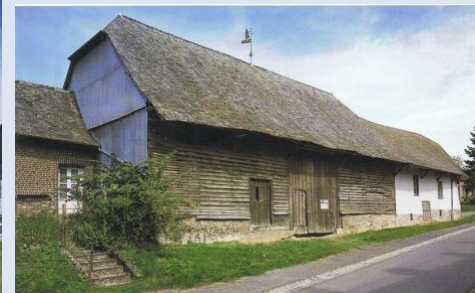
Le logis en pan de bois et torchis enduits, ouvre sur la cour, la porte visible de la rue ne conduisant qu'à une cave sous-jacente. Il se prolonge d'une longue grange en pan de bois protégé par un essentage de planches d'aulne.
