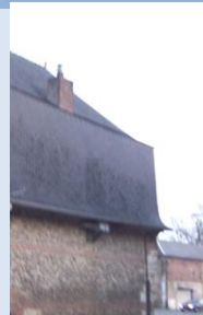
Scénographie : présence d'un toit à la mansart et de lit de silex et de brique sur la construction
