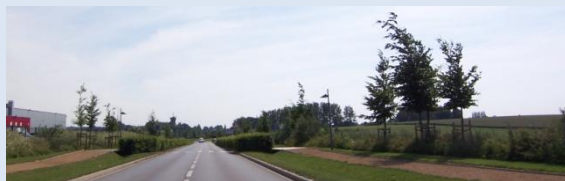
La zone d'activités Créapôle : une belle intégration paysagère
