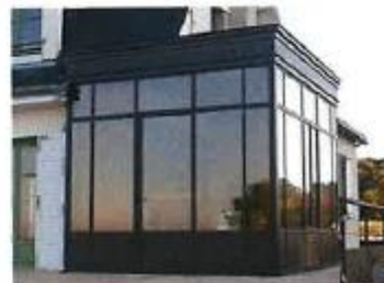
Pente de toit trop faible, ne respectant pas celle de la maison
