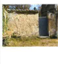
enduit à pierres vives
