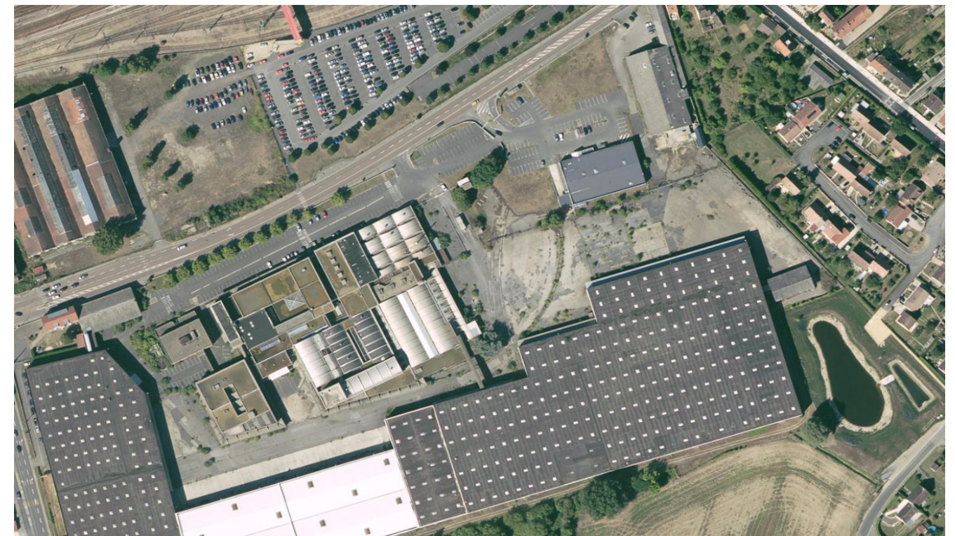
Vue aérienne du site de la friche des Coopérateurs de Champagne.
