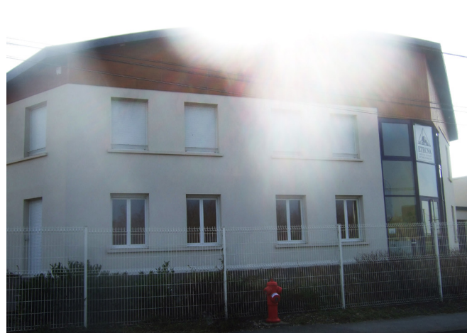
Bâtiment accueillant une entreprise de conseil aux entreprises.
