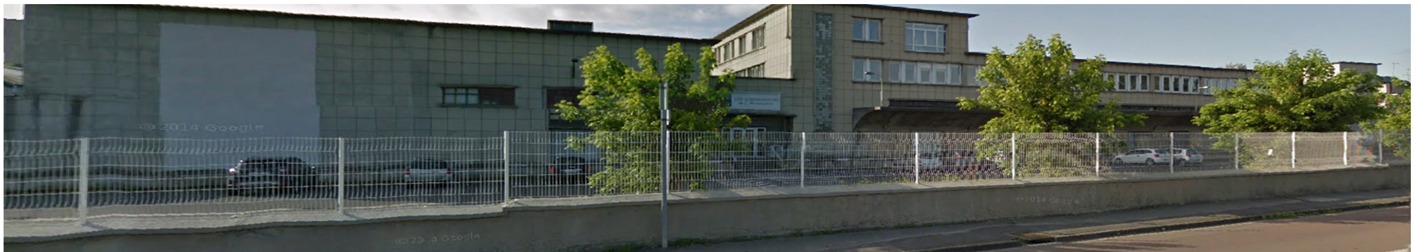
Vue du site de la friche des Coopérateurs de Champagne à revaloriser.
