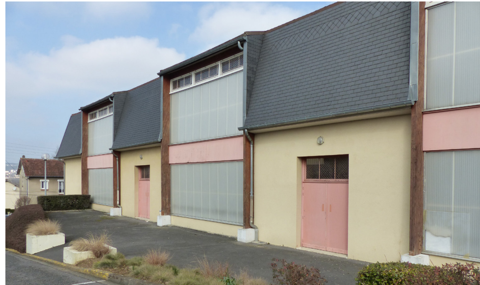
La salle omnisports est située rue des Pensées, à l'angle de la rue de Chierry.
