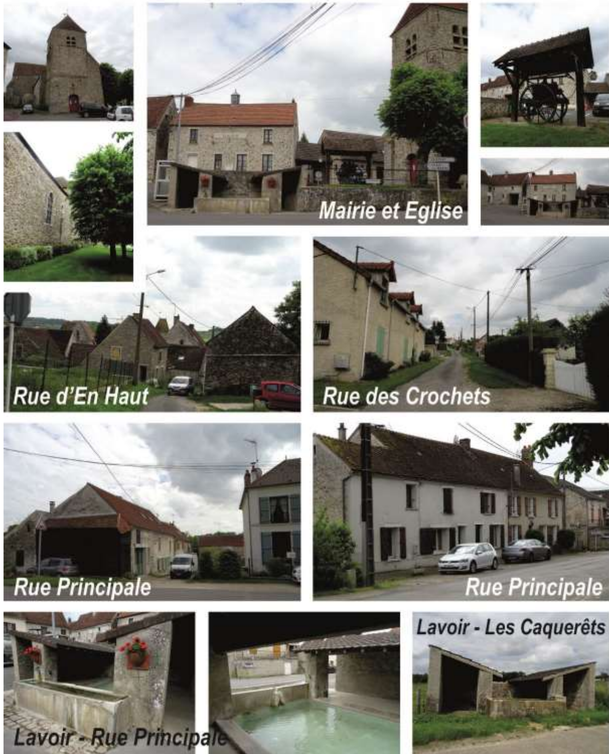
Figure 66 : illustration photographique du bâti ancien
