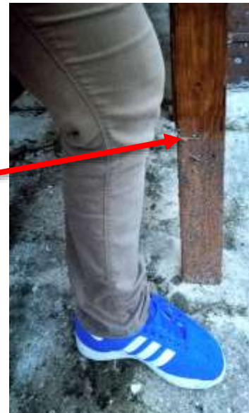
Figure 70 : Niveau atteint dans le village par une coulée de boue
