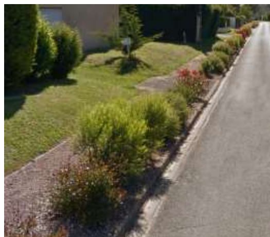
Figure 82 : Accotements de la route de Chézy à prolonger
