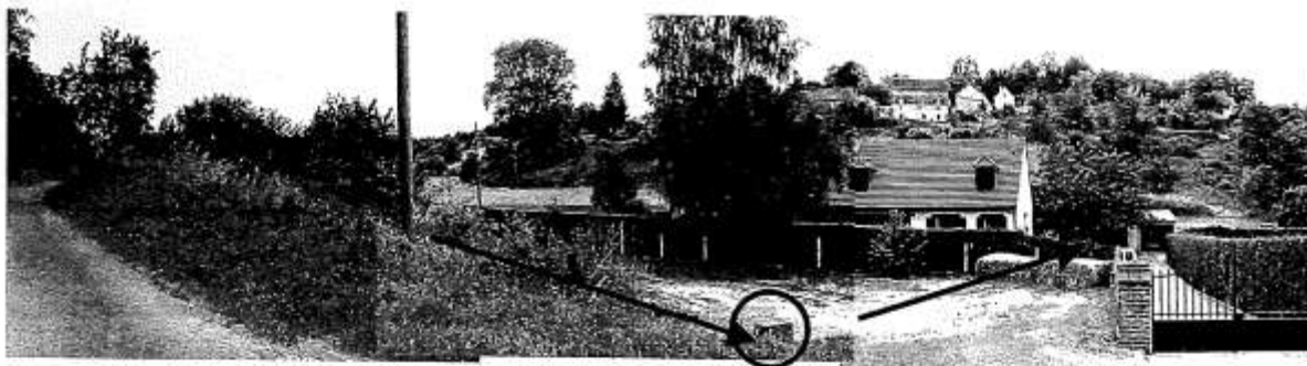
Photo 1 : Habitation de C.Lizeux et buse ayant été obstruée le 16 mai 2008
