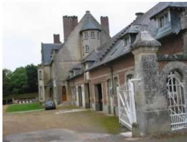
Vue actuelle de l'entrée de la ferme des Estournelles
