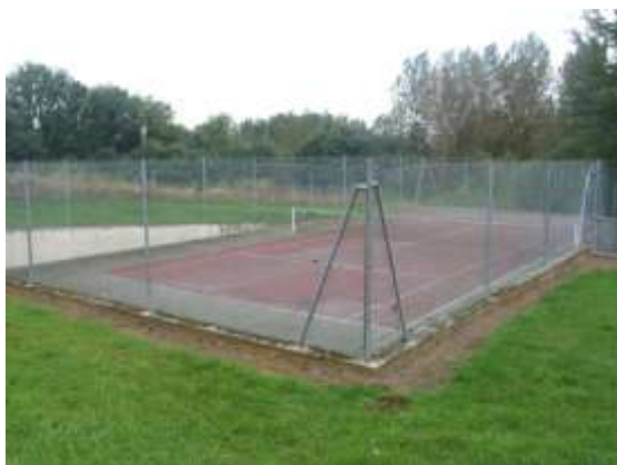
Terrain de tennis de la commune de Crécy-au-Mont Lieu-dit La Vallée
