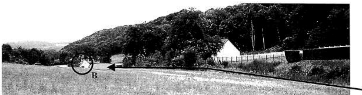
Localisation du ru, de la zone d'épanchement des eaux de ruissellement et de l'habitation sinistrée de C.Lizeux
