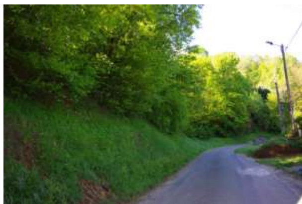
Talus boisé, rue de la Vallée
