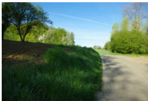
Talus « végétal », route départementale n°136
