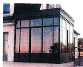
Pente de toit trop faible ne respectant pas celle de la maison
