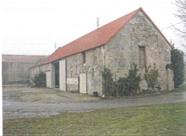
Bâtiments de l'exploitation Stragier à Party
