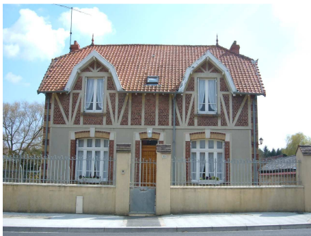
Pavillon année 60 sur sous sol apparent
