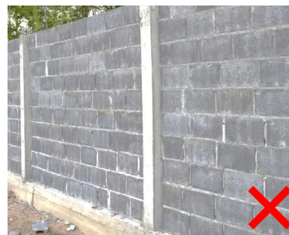
Parpaings non enduits
