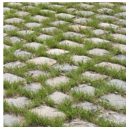
Pavés avec joints enherbés
