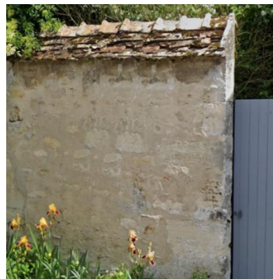
Mur en moellons à pierre vue* avec joints largement beurrés*
