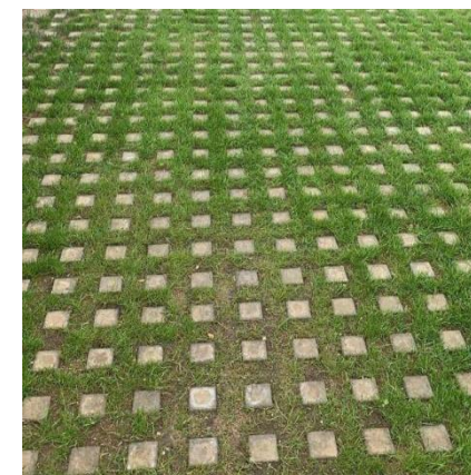
Dalles gazon en béton
