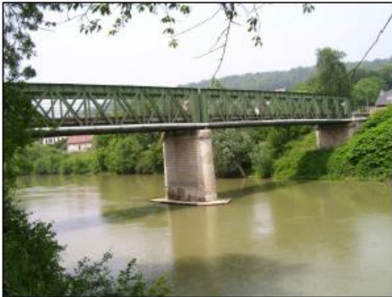
Vue générale amont du pont routier (D884)
