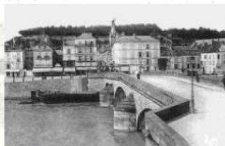
Le pont de la Marne reconstruit
