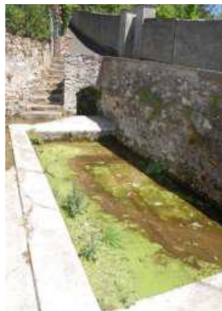
Lavoir ruelle Bungnier
