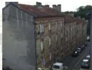
Cité ouvrière rue du Parc
