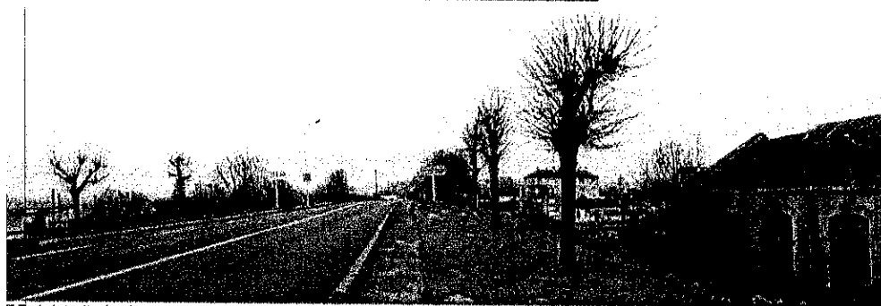
RD 1 à la limite intercommunale Etampes-sur-Marne / Château-Thierry
