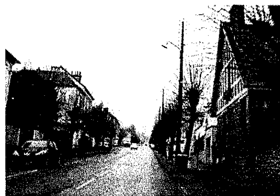
Avenue de Soissons
