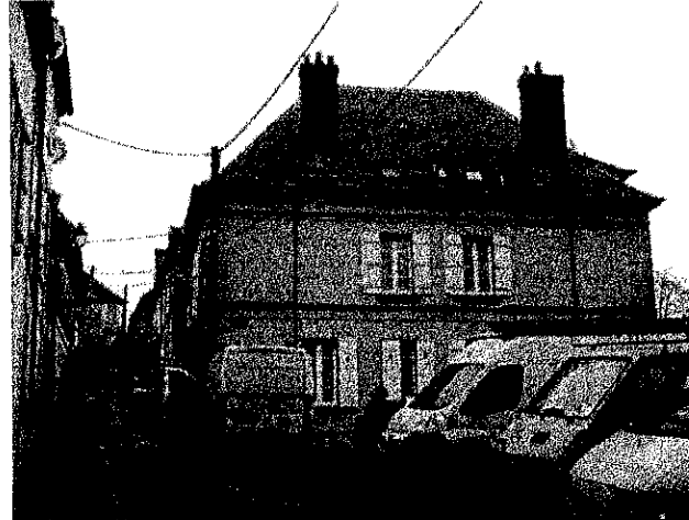
Rue du Château - Elargissement ponctuel de l'espace public : placette permettant l'ouverture d'une façade latérale.
