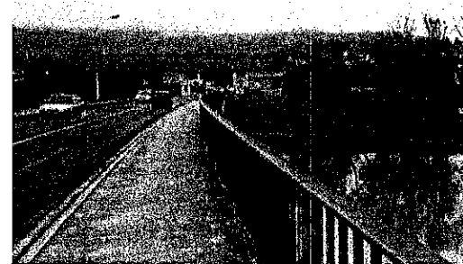
RD 1003, pont de la Marne, vue 2
