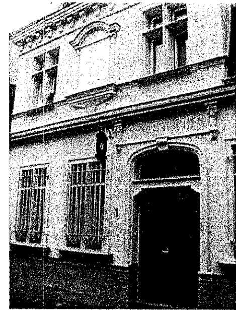
N° 8 rue du Château : Bains-douches Construction réalisée en 1923 et financée par la Caisse d'Epargne de Château-Thierry (d'après l'inscription sur la façade). La forme des baies à meneaux est inspirée librement du 16 ème siècle. Le crépi de plâtre imite la pierre de taille.
