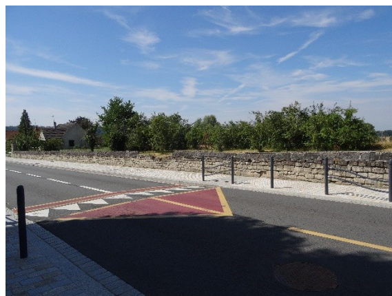
Mur de clôture de long de la rue du Chemin des Dames
