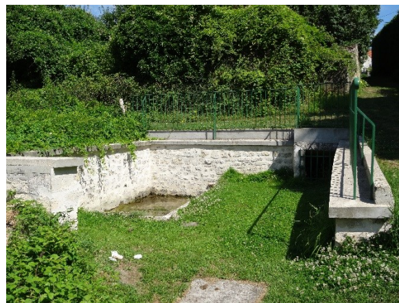
N°4 : Ancien lavoir
